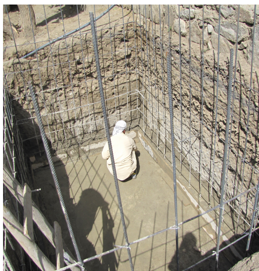
Construction du réservoir
