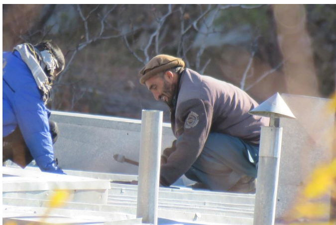
L'ouvrier répare le toit du lycée de garçons
