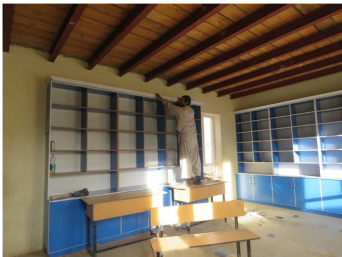
Pose des armoires dans la bibliothèque
