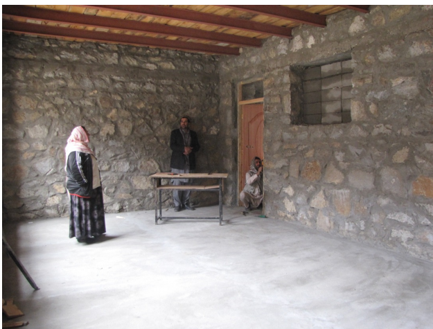
Le sol est cimenté, fenêtres et porte sont posées.
