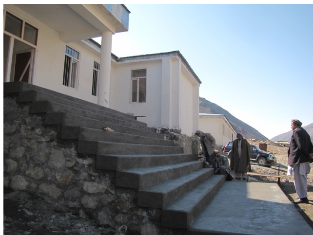
A la fin des travaux : Le grand escalier a été complètement cimenté et peut maintenant être utilisé
