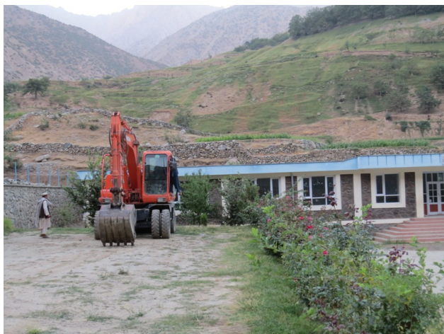
L'excavateur devant le collège de Bajgah avant le début des travaux
