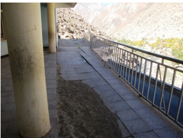
Avant les travaux : la terrasse surplombant le mur de soutènement est abîmée et laisse l'eau de pluie s'infiltrer, ce qui a provoqué l'effondrement du mur
