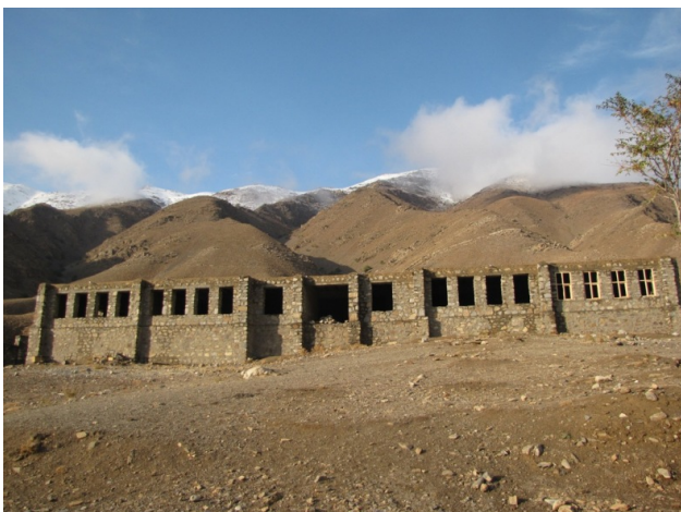
Le lycée de filles de Sangona construit par le gouvernement il y a 4 ans et jamais terminé
