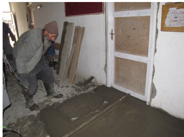
Fin des travaux de cimentage du couloir
