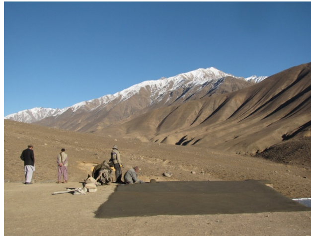
Le toit au dessus de la bibliothèque est cimenté
