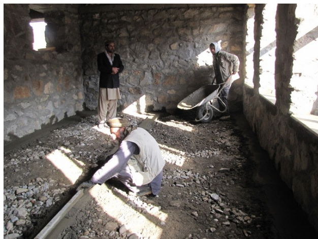
Une pièce va être transformée par NEGAR en bibliothèque
