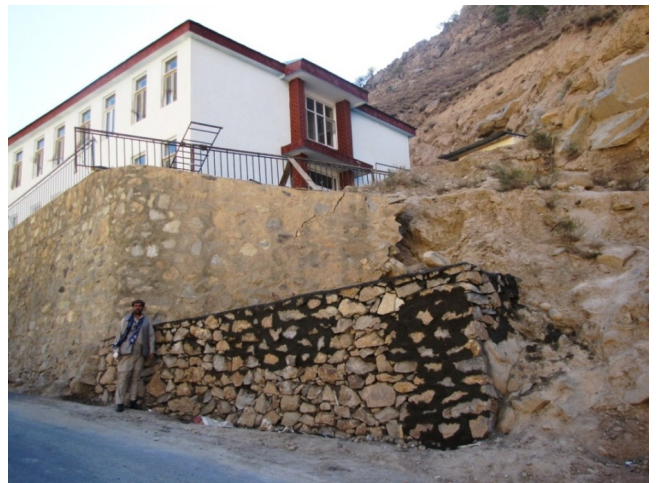
Après les travaux : un mur de consolidation a été construit
