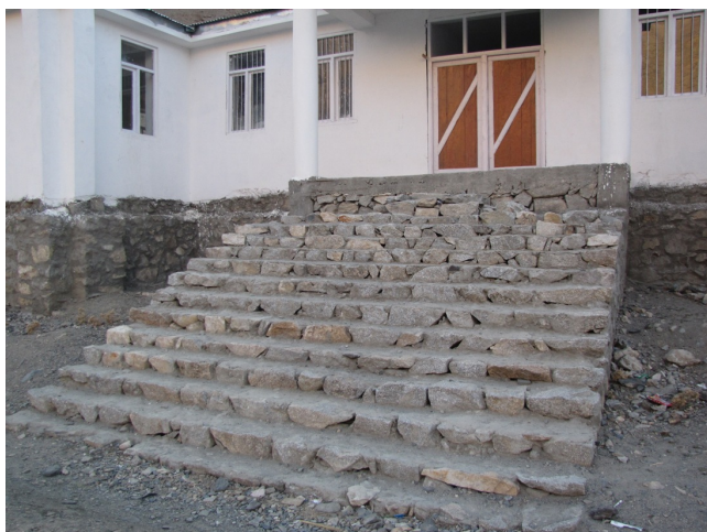
Avant les travaux : le grand escalier n'a jamais été terminé
