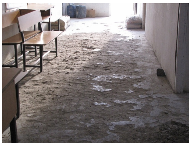
Avant les travaux : le ciment s'est complètement effrité dans le couloir
