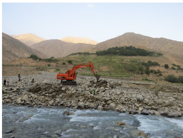
Début des travaux : creusement d'un chemin pour dévier les glissements de terrain de façon à ce qu'ils évitent le collège et rejoignent la rivière
