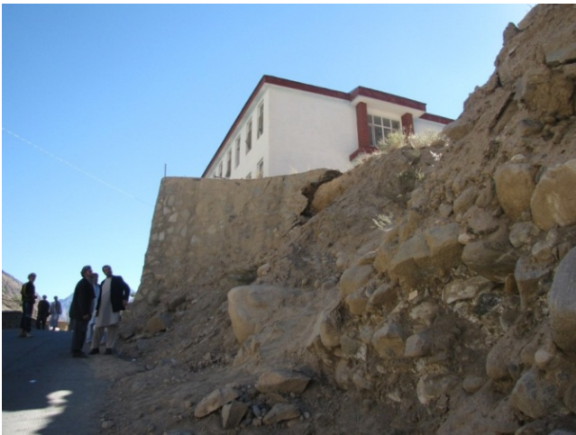
Avant les travaux : une partie du mur de soutènement s'est effondré
