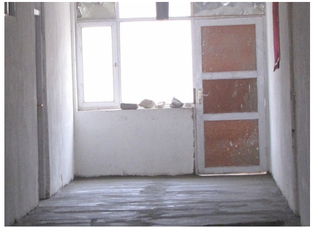
Le sol a été cimenté et toutes les vitres manquantes ont été posées.
