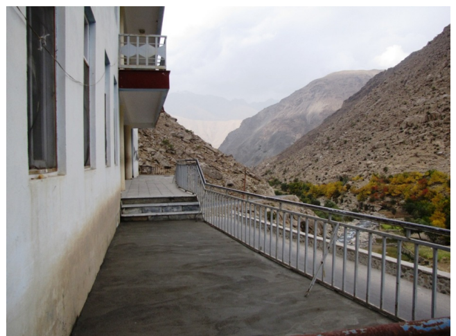
Après les travaux : la terrasse a été complètement cimentée, un chemin d'évacuation de l'eau a été aménagé et l'extrémité de la terrasse clôturée.
