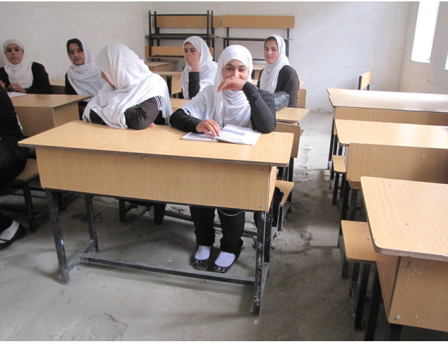
Le ciment des salles de classe s'est complètement effrité
